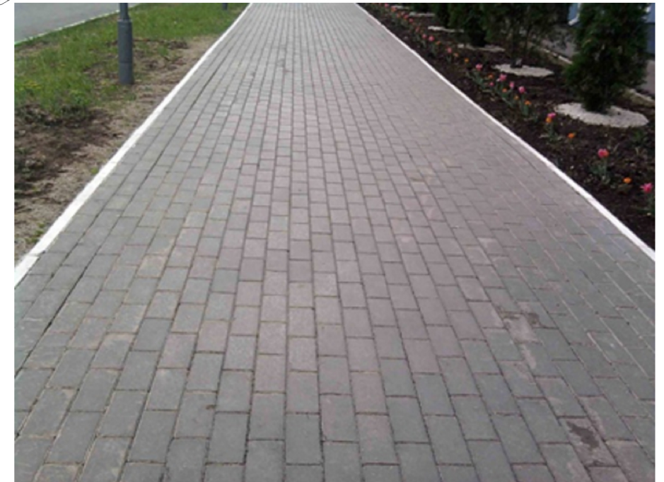
Покрытие тротуарная плитка типа "Кирпичик"
